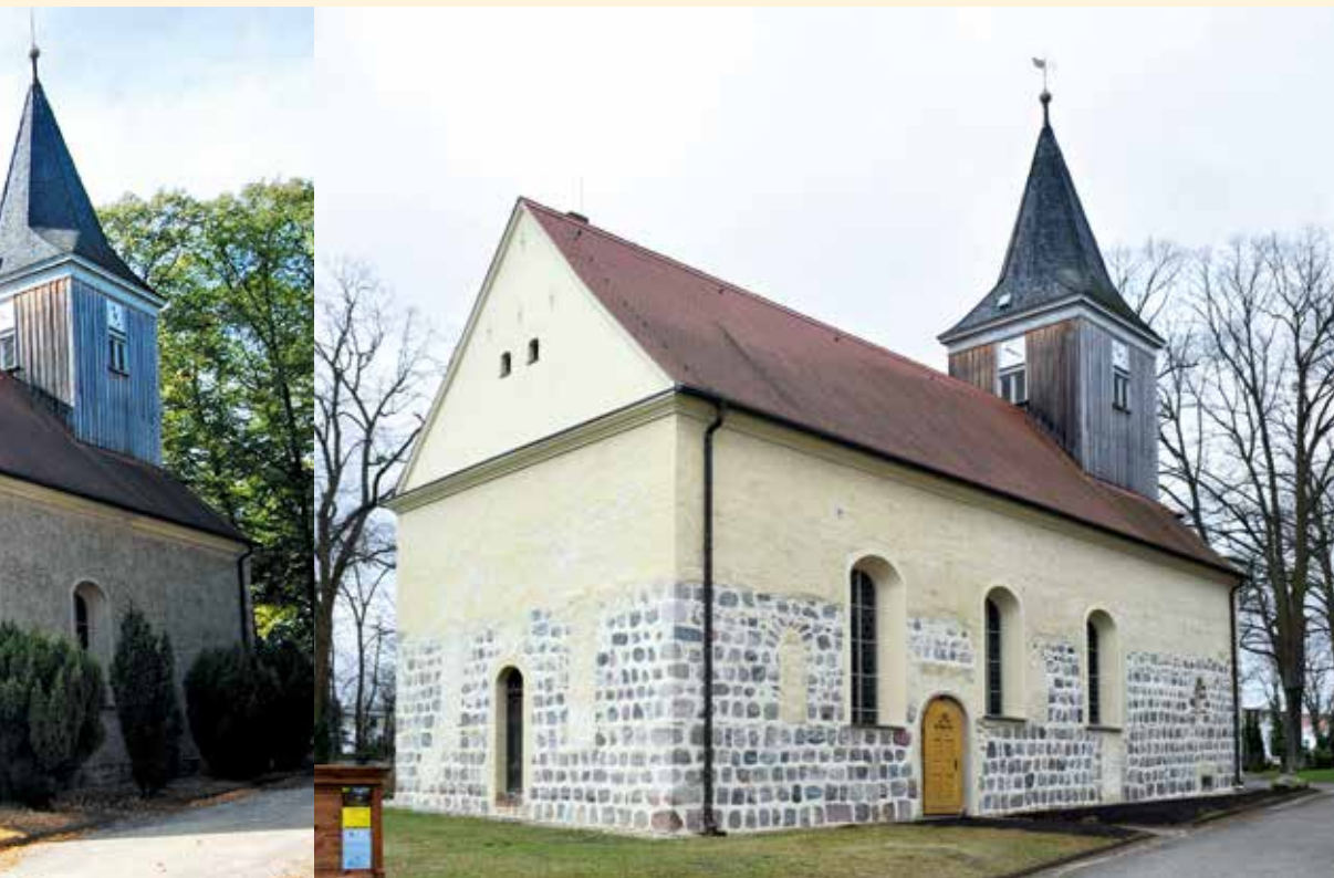
Dorfkirche Groß Glienicke nach der Putzabnahme und Neuverfugung; Fotos: Doreen Duras
